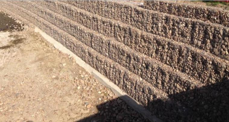
Los gaviones de malla de alambre de acero de triple torsión **GTT-GDM** se suministran en diferentes medidas, para su aplicación en la construcción de estructuras EN obra civil de diferente tipología (Contenciones de tierras, protección y/o revestimiento de cauces, formación de terrazas, muros reforzados...).
