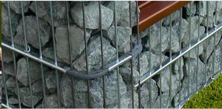
Los gaviones tipo **REDHEN®**, se fabrican a partir de paneles de medidas estándar para la composición de cualquier tamaño y forma requerida por el cliente, disponiendo en catálogo de una amplia gama de elementos prediseñados como floreros o bancos.
