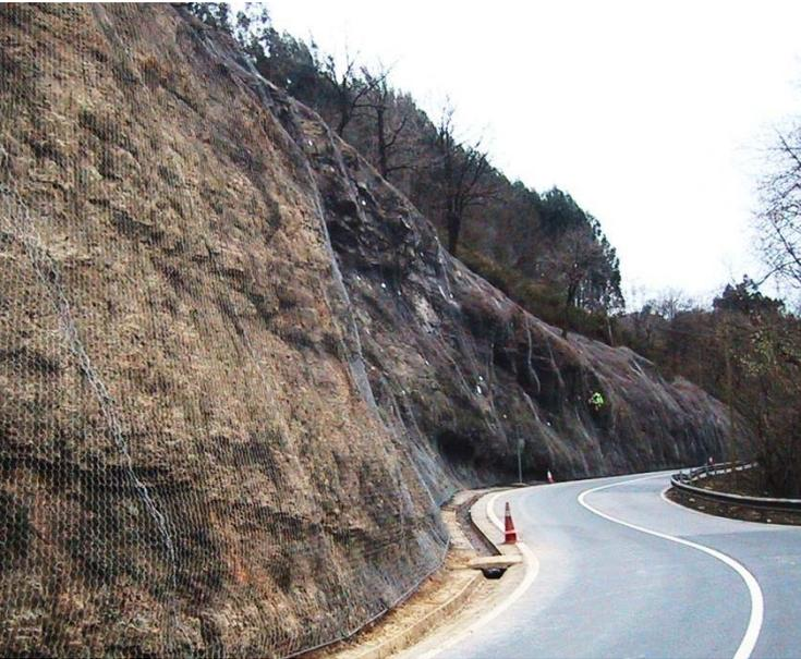
Los enrejados de malla de alambre de acero de triple torsión **TT-GDM** se utilizan para aplicaciones de ingeniería civil, principalmente para la protección de taludes inestables y control de desprendimientos.
